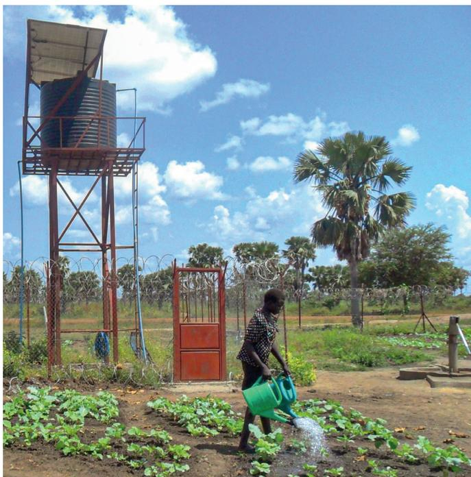
Wasser für den Gemüseanbau auf einem Acker in der Größe eines Fußballfeldes. Die am Wassertank montierten Solarpaneele liefern den Strom, der nötig ist, um das Wasser aus der Tiefe zu pumpen.
